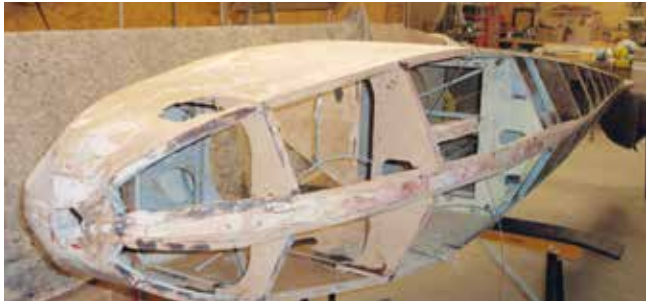
Fehlerhafte Verleimungen erforderten viele Stunden Arbeit. Glue failure lead to many hours hard work.
